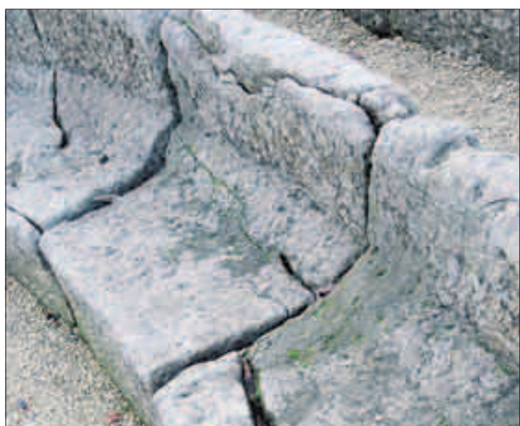
Der Frost hat dem Stein in den vergangenen Jahren zugesetzt.
